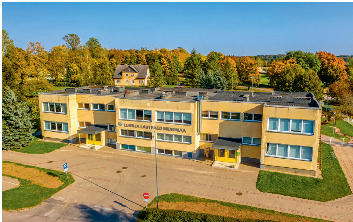
Lasteaia Midrimaa kinnistu ootab renoveerimist ja juurdeehitust. Foto: Ragnar Vutt
