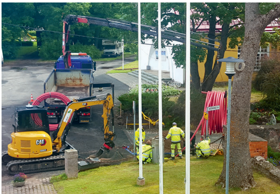
Tööd valguskaabli paigaldamisega käivad täies hoos. Foto: Aare Anderson
