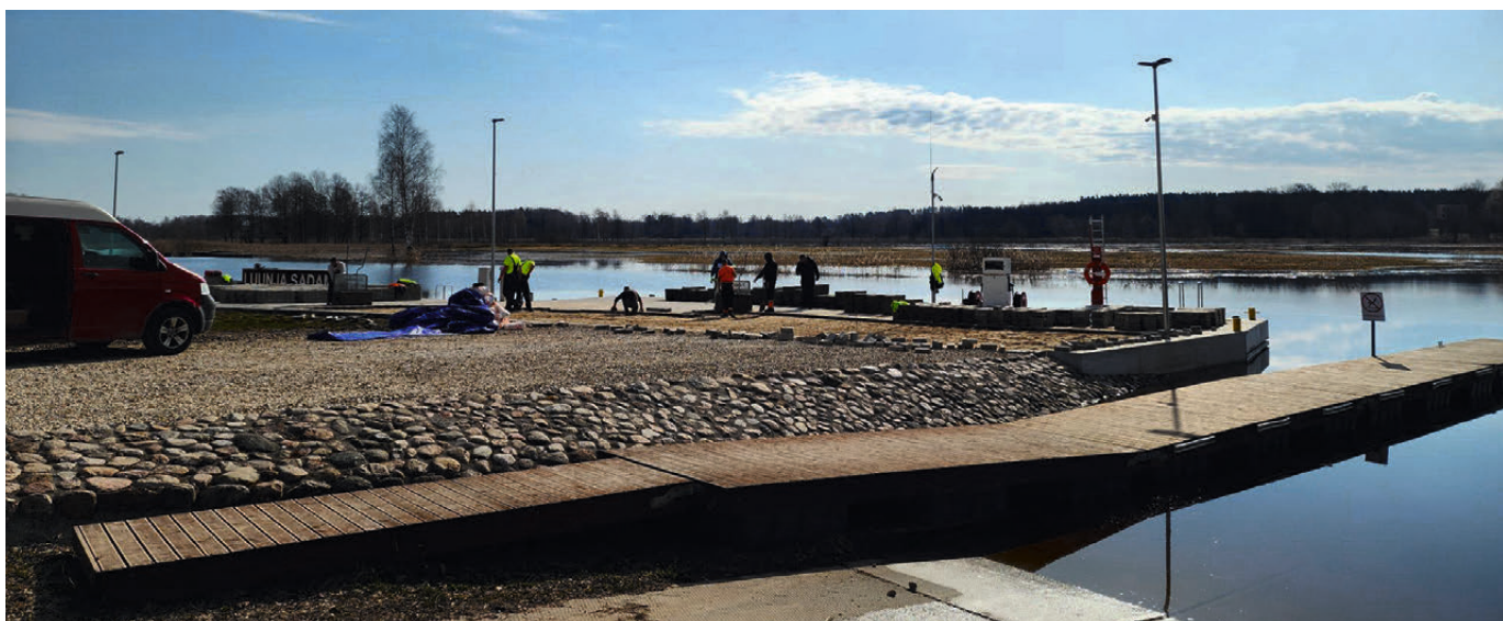
Sadama betoonkai kiviplatsi ehitustööd. Foto: Tarvo Laas
