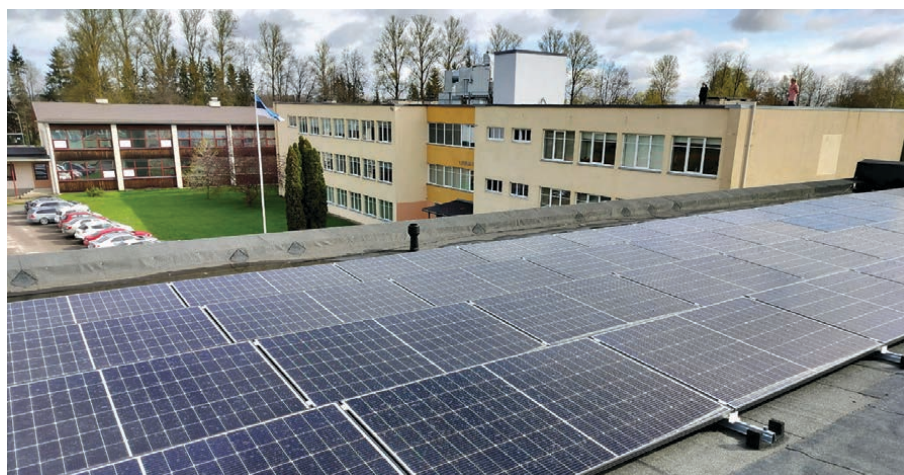
Päikesepaneelid on paigaldatud ja töötavad. Foto: Toomas Liivamägi
